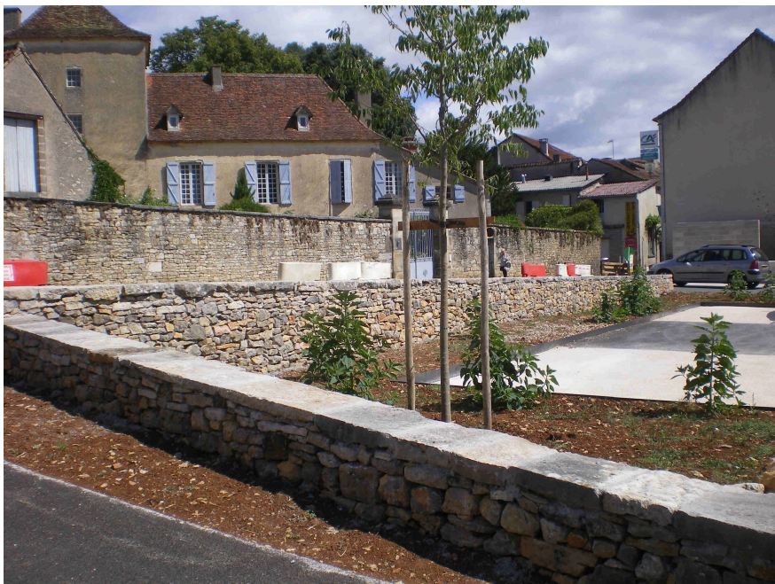
mur du nouveau parking route de Cahors.
